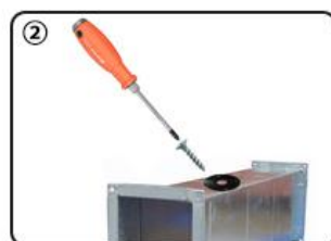
用螺丝将法兰盘固定在排风管上
