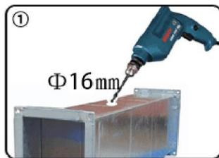
① 在非风管上打一个直径16mm的孔
