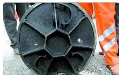
第一步：用专用工具打开井盖，将井盖放置平稳
