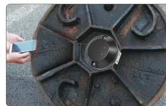
第四步：支架和井盖的安装 注意产品不要紧贴井盖面，离的太近会影响信号传输
