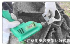
第二步：选择合适安装位置，确定传感器安装位置并使用电钻打孔 注意安装支架比好位置
