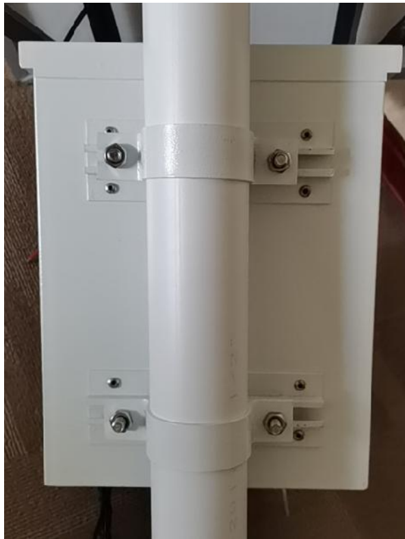
安装完成背面图
