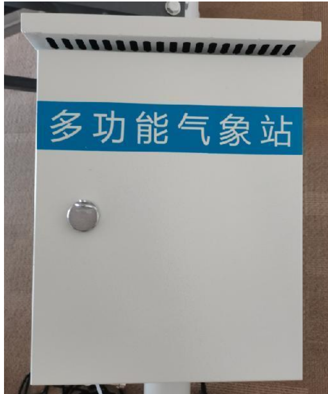
安装完成正面图
