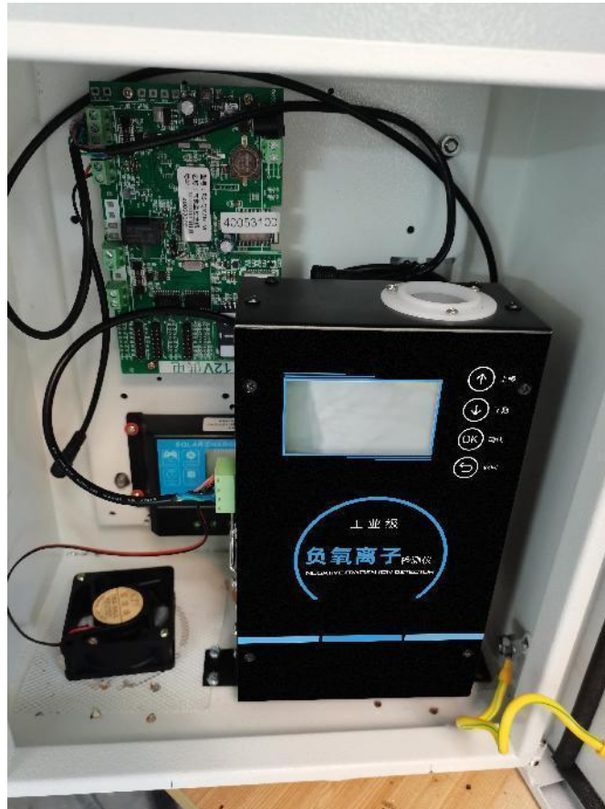
安装完成正面图
