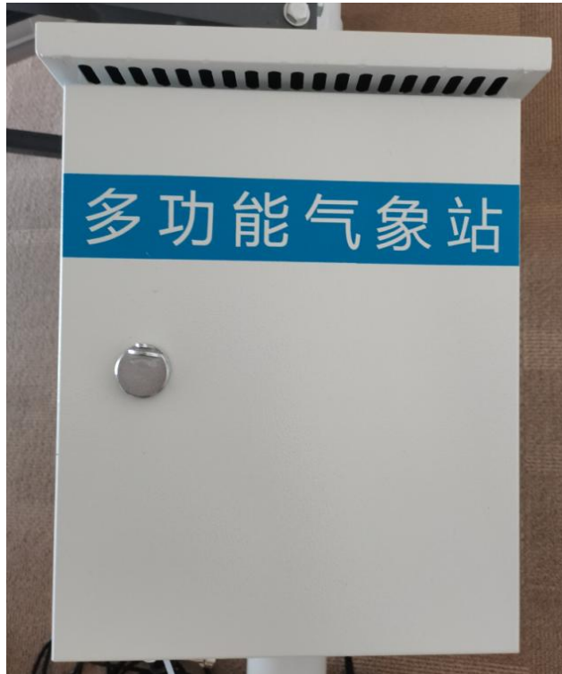
安装完成正面图
