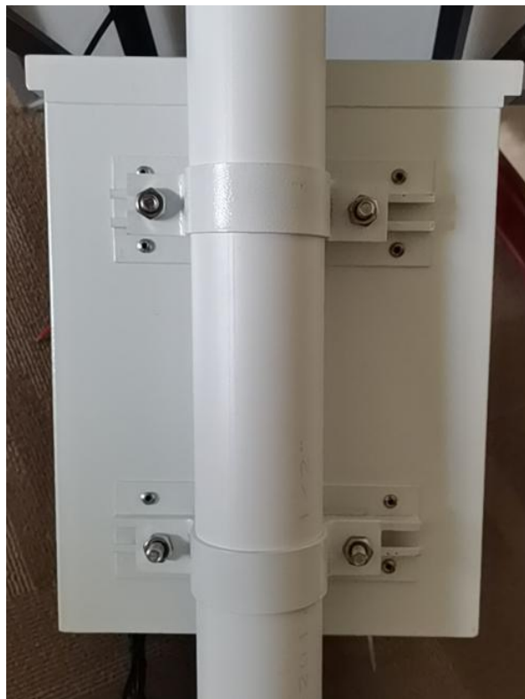
安装完成背面图
