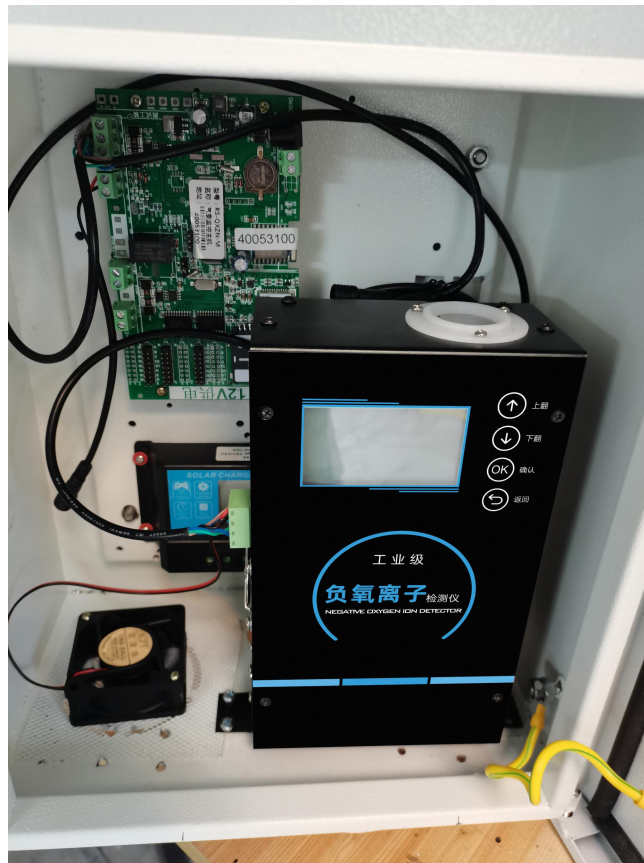
安装完成正面图
