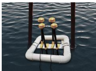
(2) PVC管材支架安装
