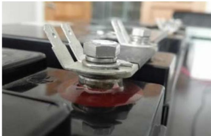
在所有安装调试工作结束后, 必须对每个电池极柱螺丝松紧度进行检查。
